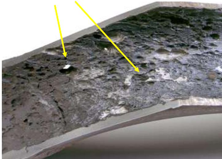
Picaduras por oxígeno
