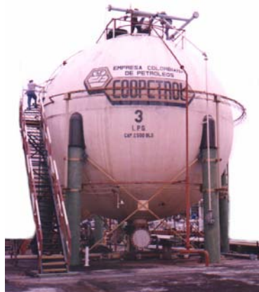
Inspección mecánica de una esfera de almacenamiento de GLP
